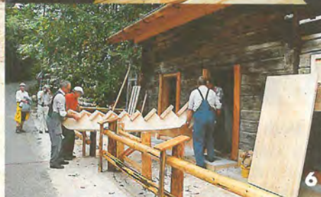
Ehe die neue Informationsstelle Engert-Holzstube fertig dastand, wurde das Gebäude aufgebockt (Bild 1), auf Eisenträger gesetzt (2), mit „Hebmandln“ verschoben (3), gründlich saniert (4), frisch gedeckt (5), neu ausgestattet (6) und feierlich eingeweiht (7).
