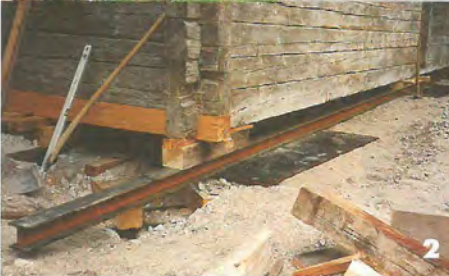
Ehe die neue Informationsstelle Engert-Holzstube fertig dastand, wurde das Gebäude aufgebockt (Bild 1), auf Eisenträger gesetzt (2), mit „Hebmandln“ verschoben (3), gründlich saniert (4), frisch gedeckt (5), neu ausgestattet (6) und feierlich eingeweiht (7).
