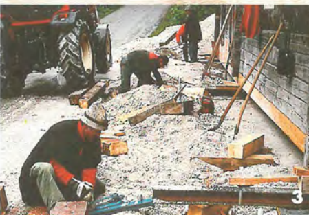
Ehe die neue Informationsstelle Engert-Holzstube fertig dastand, wurde das Gebäude aufgebockt (Bild 1), auf Eisenträger gesetzt (2), mit „Hebmandln“ verschoben (3), gründlich saniert (4), frisch gedeckt (5), neu ausgestattet (6) und feierlich eingeweiht (7).
